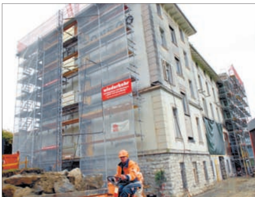
Die ersten Baugerüste stehen bereits am Hotel Honegg. Mindestens ein Jahr werden die Renovationen dauern.
